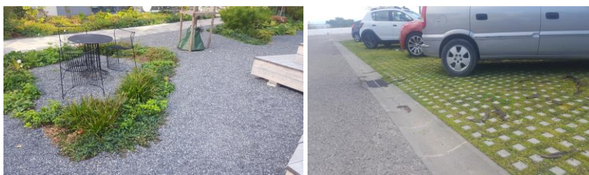
Figur 21. I vänstra bilden visas ett exempel på permeabel beläggning på en innegård. Till höger visas exempel på en rasteryta med gräs som ökar genomsläppligheten och som kan användas på parkeringsytor. Foto: Sweco.
