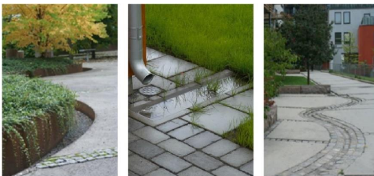
Figur 23. Exempel på utformning av dagvattenrännor i urban miljö. (Det högra och vänstra exemplet är foton från Sweco, exemplet i mitten kommer från S:t Eriks rännalsplattor)
