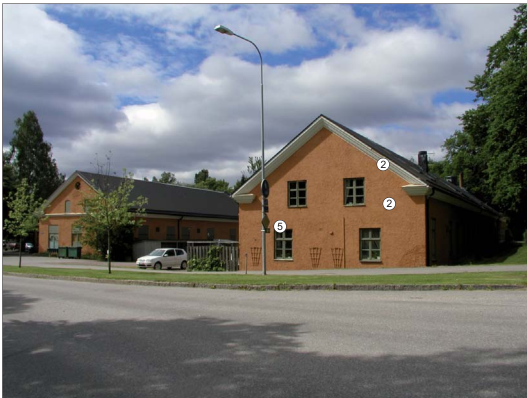
Bruksvägen 3. Karaktärsskapande arkitekturelement markerade.
