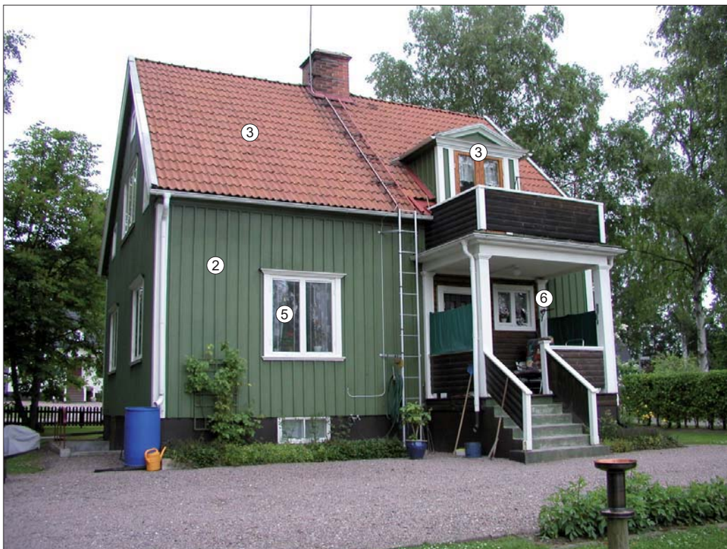
Brännkärrsgatan 17, bostadshuset. Karaktärsskapande arkitekturelement markerade.
