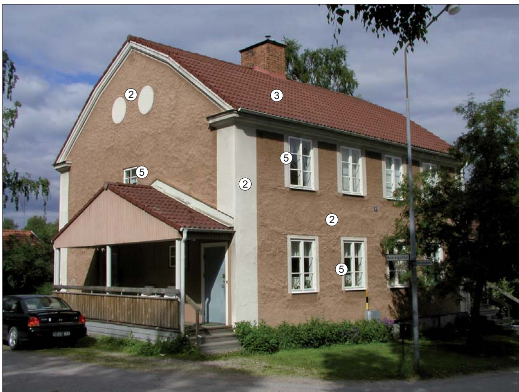
Bergsgatan 8. Karaktärsskapande arkitekturelement markerade.
