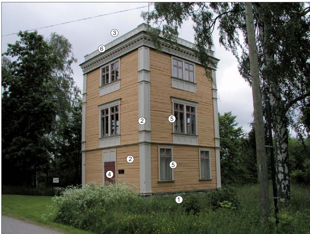
Kornskruven. Karaktärsskapande arkitekturelement markerade.
