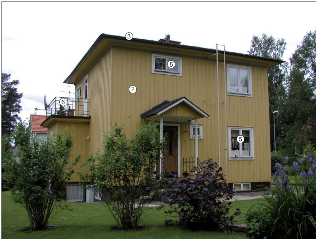
Thomasgatan 3, bostadshuset. Karaktärsskapande arkitekturelement markerade.
