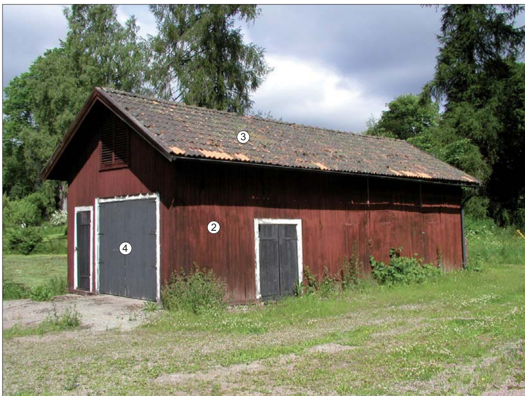
Uthuset. Karaktärsskapande arkitekturelement markerade.
