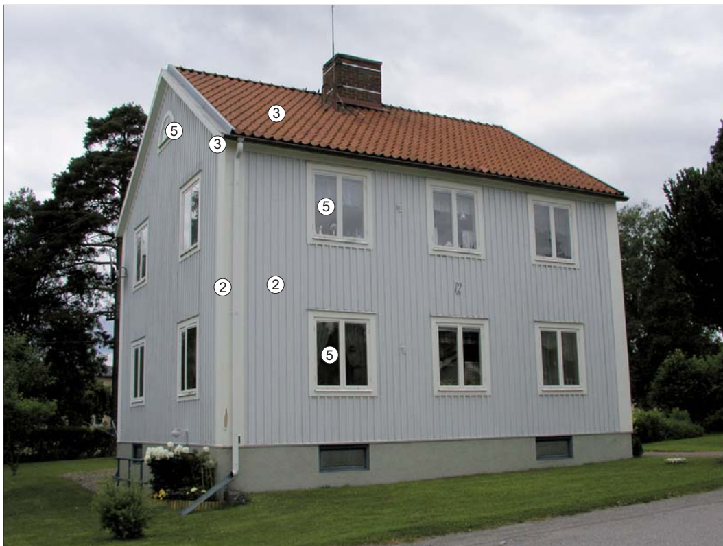
Smålandsgatan 12, huvudbyggnaden sedd från gatan. Karaktärsskapande arkitekturelement markerade.
