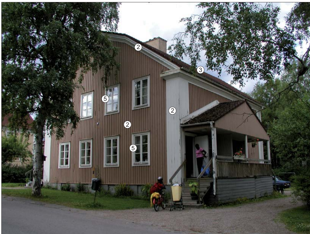
Bergsgatan 4. Karaktärsskapande arkitekturelement markerade.
