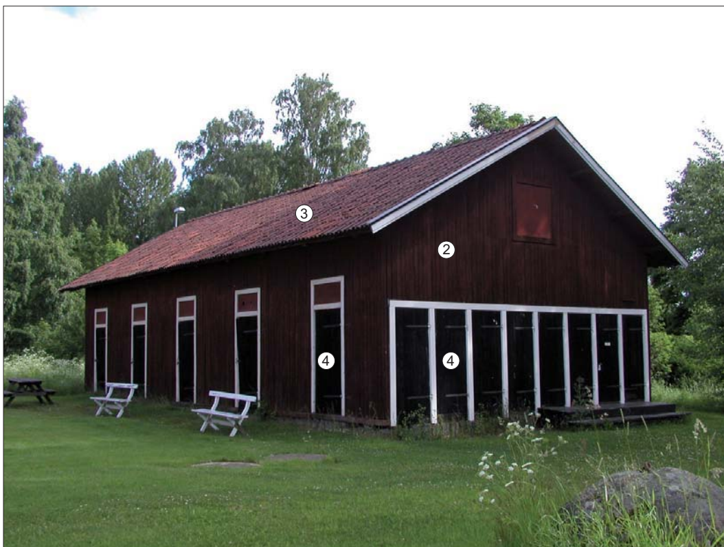
Storgatan 15, uthuset. Karaktärsskapande arkitekturelement markerade.
