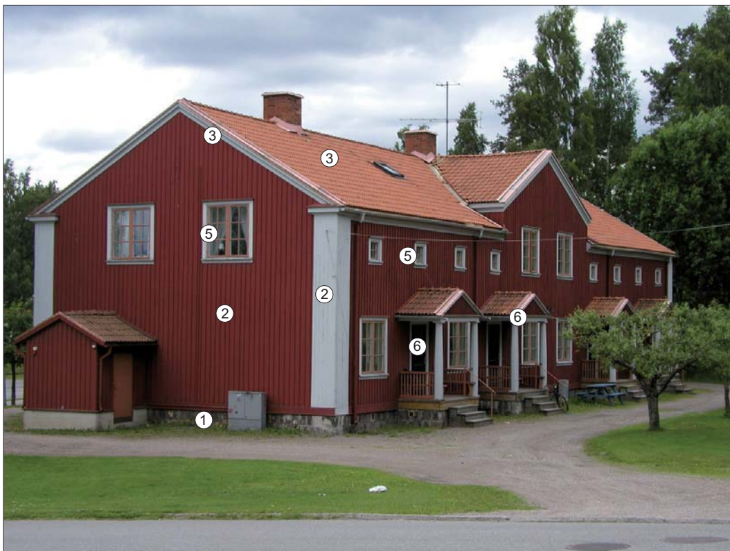
Storgatan 34. Bostadshuset. Karaktärsskapande arkitekturelement markerade.
