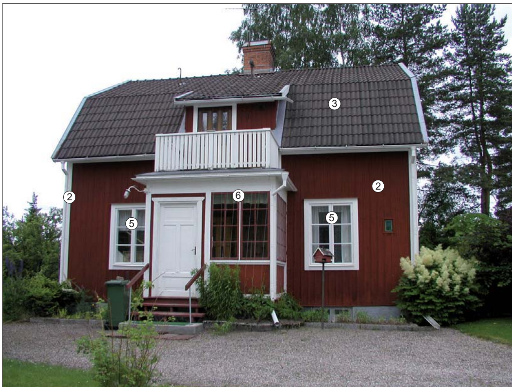
Brännkärrsgatan 9, bostadshuset. Karaktärsskapande arkitekturelement markerade.
