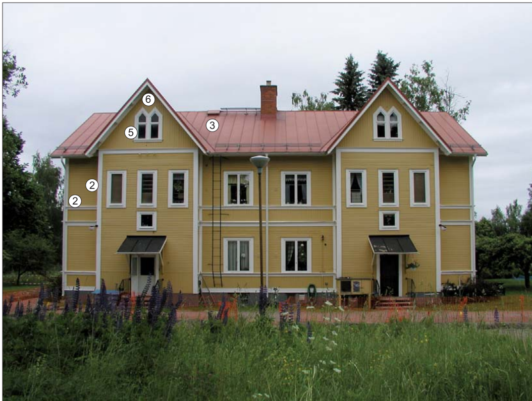
Lärbostad. Karaktärsskapande arkitekturelement markerade.
