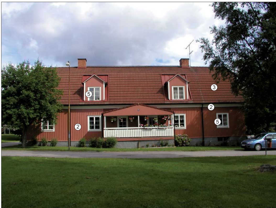
Bryggargatan 2. Karaktärsskapande arkitekturelement markerade.
