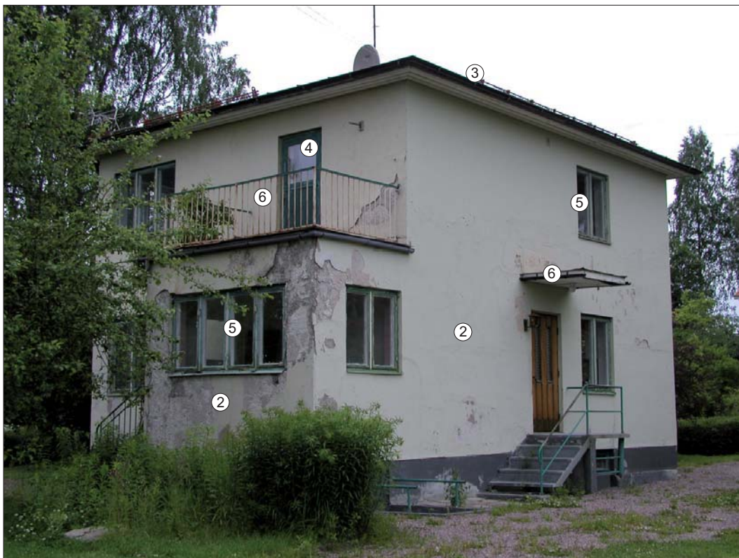
Brännskärsgatan 23, bostadshuset. Karaktärsskapande arkitekturelement markerade.
