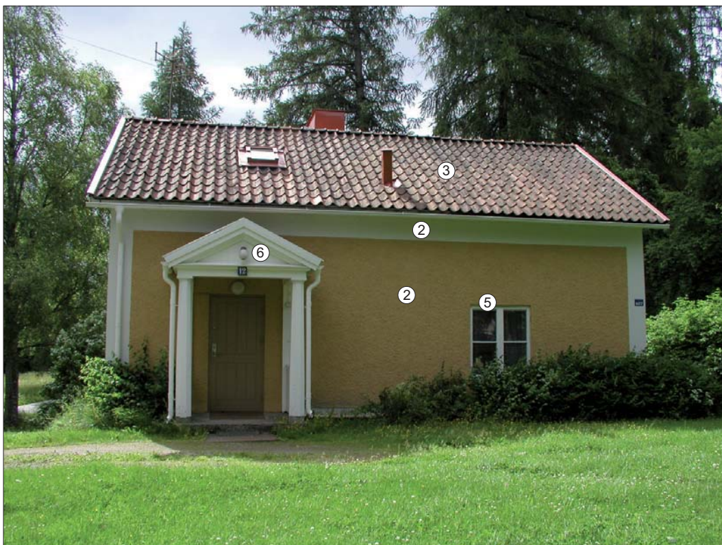
Bruksvägen 12. Karaktärsskapande arkitekturelement markerade.
