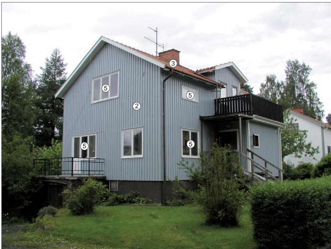
Thomasgatan 6, bostadshuset. Karaktärsskapande arkitekturelement markerade.
