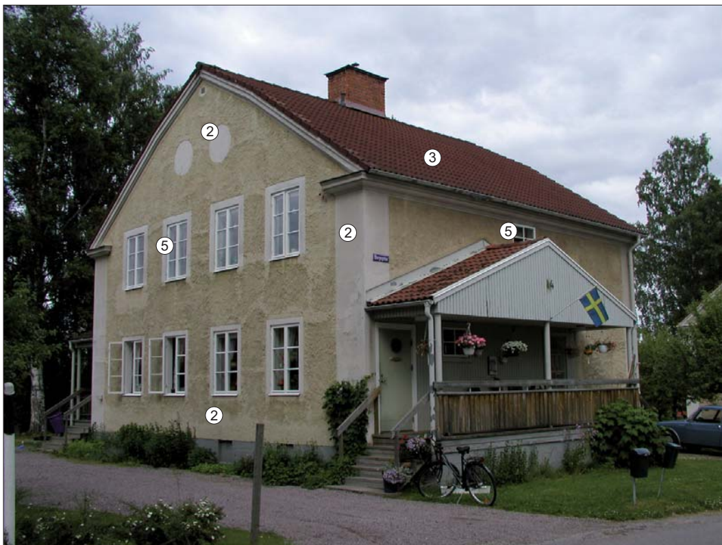
Bergsgatan 14. Karaktärsskapande arkitekturelement markerade.
