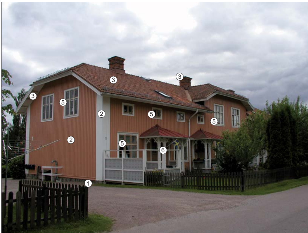
Synargatan 3. Karaktärsskapande arkitekturelement markerade.
