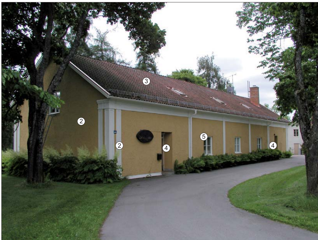
Bruksvägen 10. Karaktärsskapande arkitekturelement markerade.
