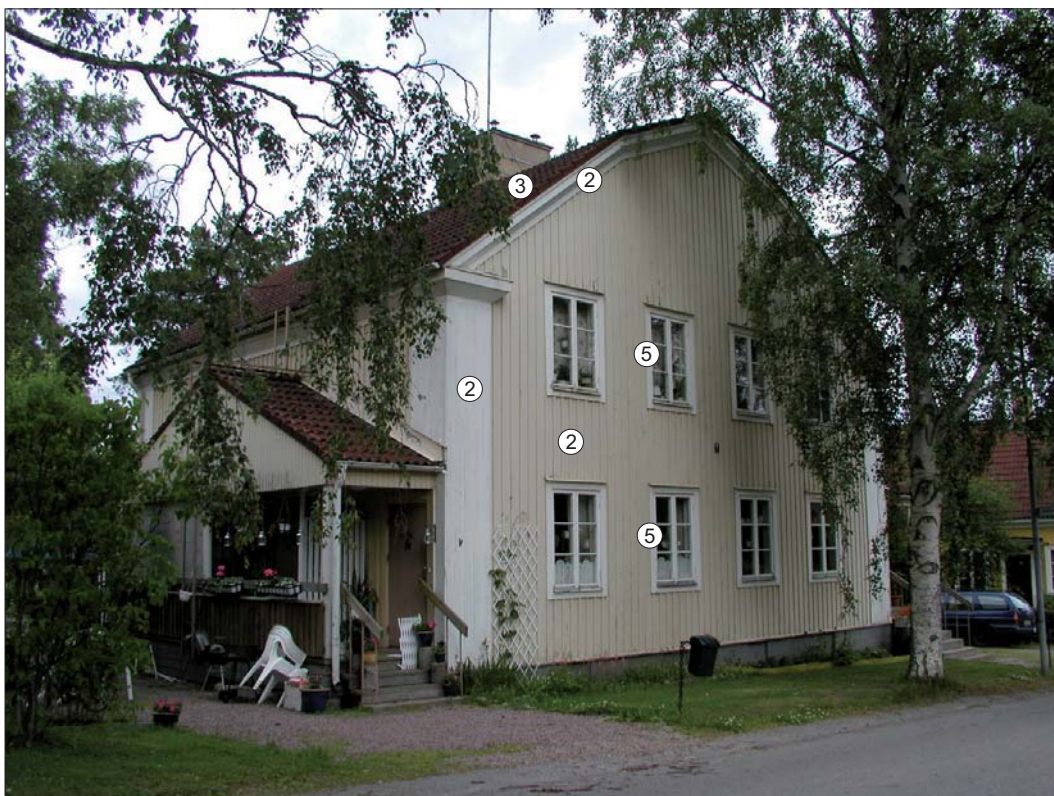
Bergsgatan 2. Karaktärsskapande arkitekturelement markerade.
