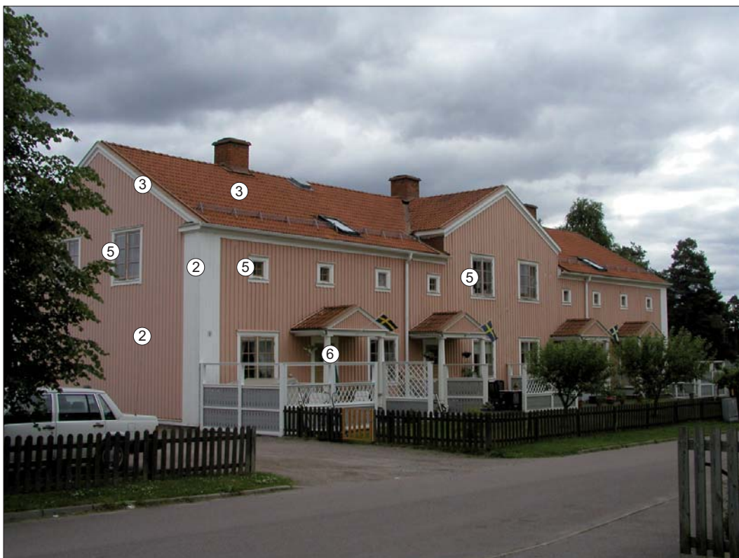
Synargatan 9. Karaktärsskapande arkitekturelement markerade.
