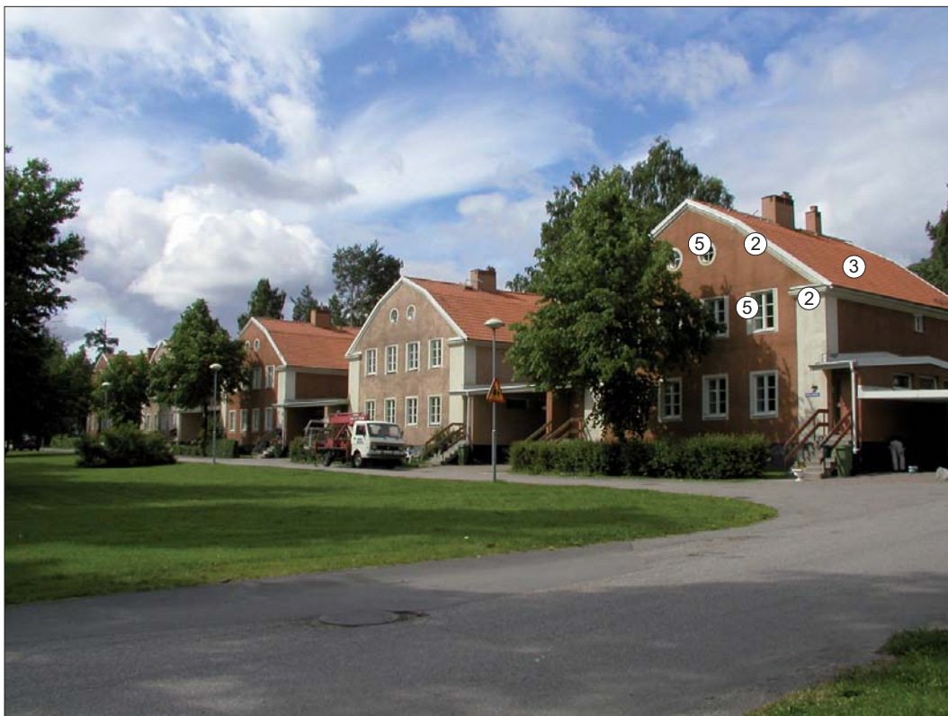
Västra Parkgatan 6–14. Karaktärsskapande arkitekturelement markerade.
