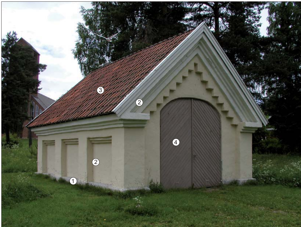
Hantverkargatan 2, likboden. Karaktärsskapande arkitekturelement markerade.
