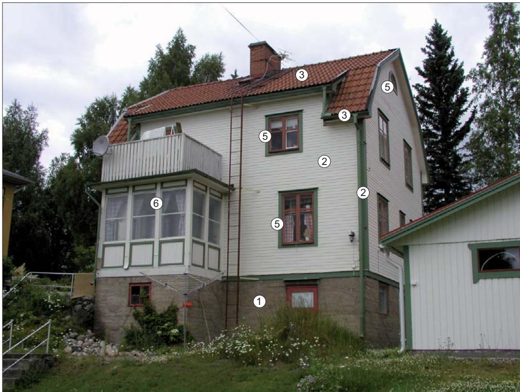
Tallmogatan 3. Karaktärsskapande arkitekturelement markerade.
