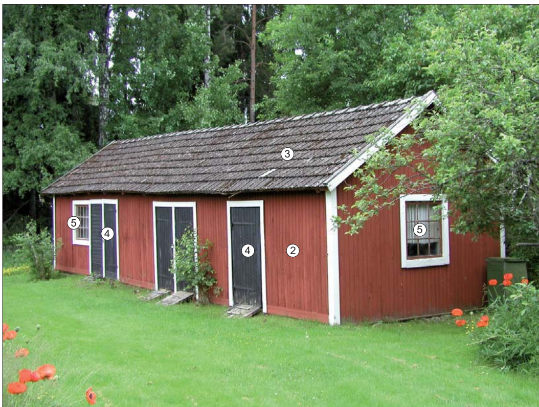
Brännkärrsgatan 9, uthuset. Karaktärsskapande arkitekturelement markerade.
