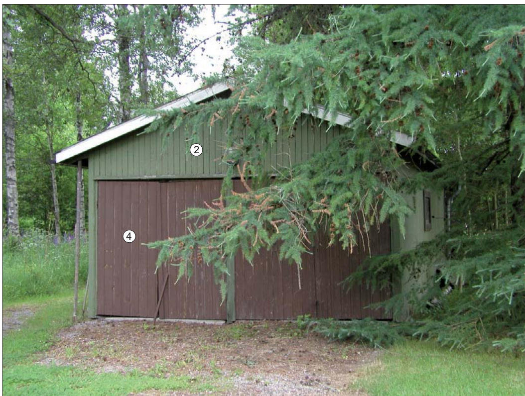
Thomasgatan 6, garaget. Karaktärsskapande arkitekturelement markerade.
