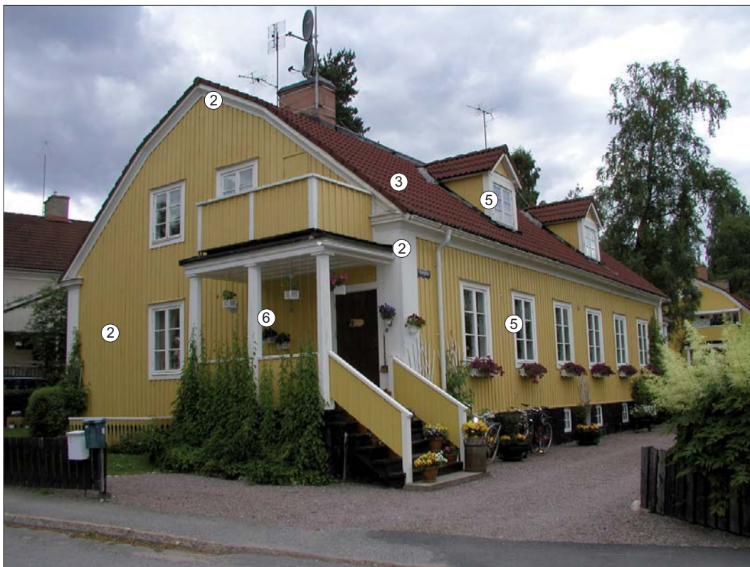
Storgatan 12. Karaktärsskapande arkitekturelement markerade.
