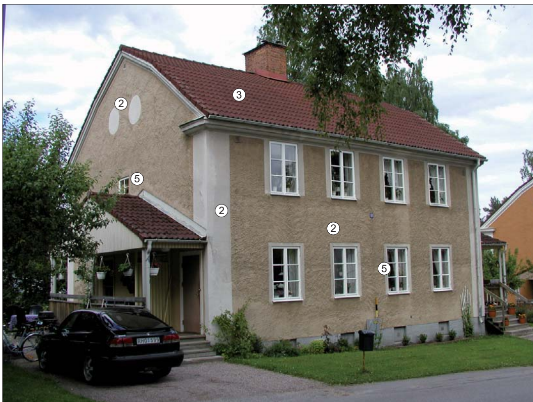
Bergsgatan 12. Karaktärsskapande arkitekturelement markerade.
