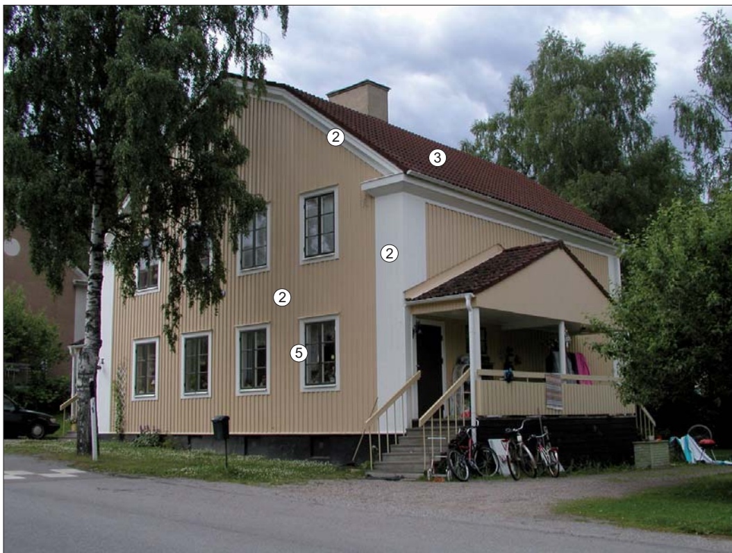
Bergsgatan 6. Karaktärsskapande arkitekturelement markerade.
