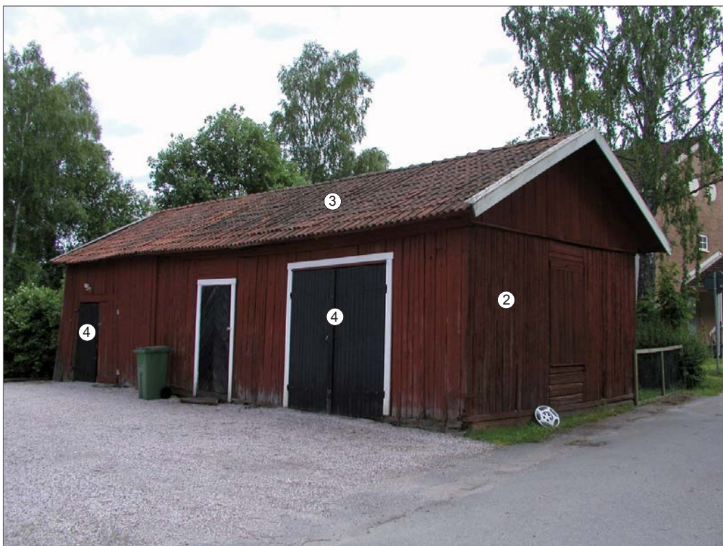
Armégatan 5, uthuset. Karaktärsskapande arkitekturelement markerade.
