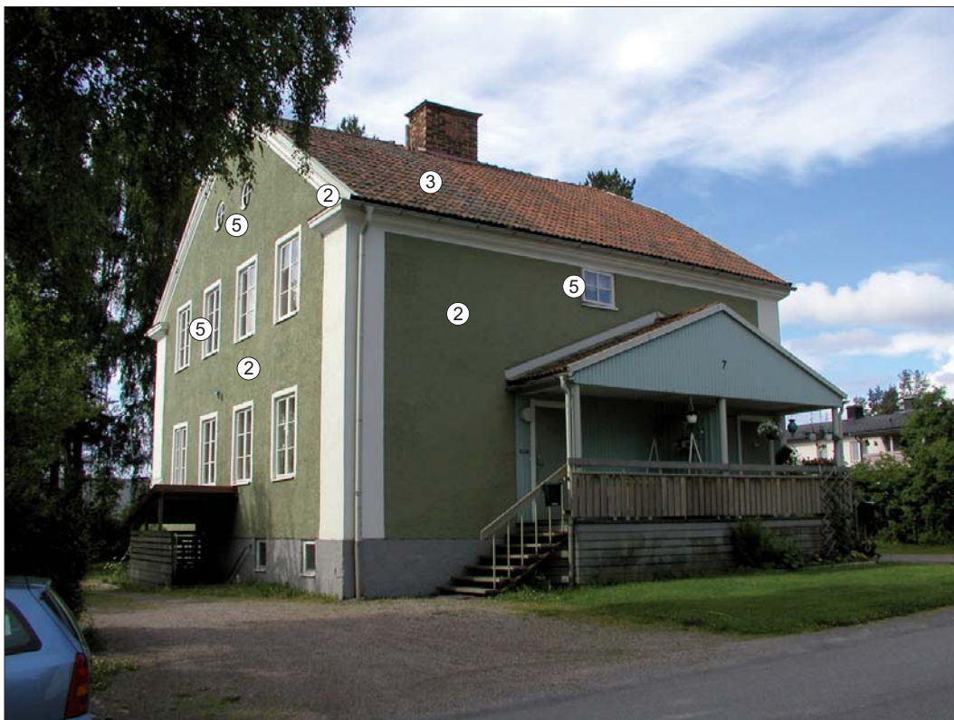
Bergsgatan 7. Karaktärsskapande arkitekturelement markerade.
