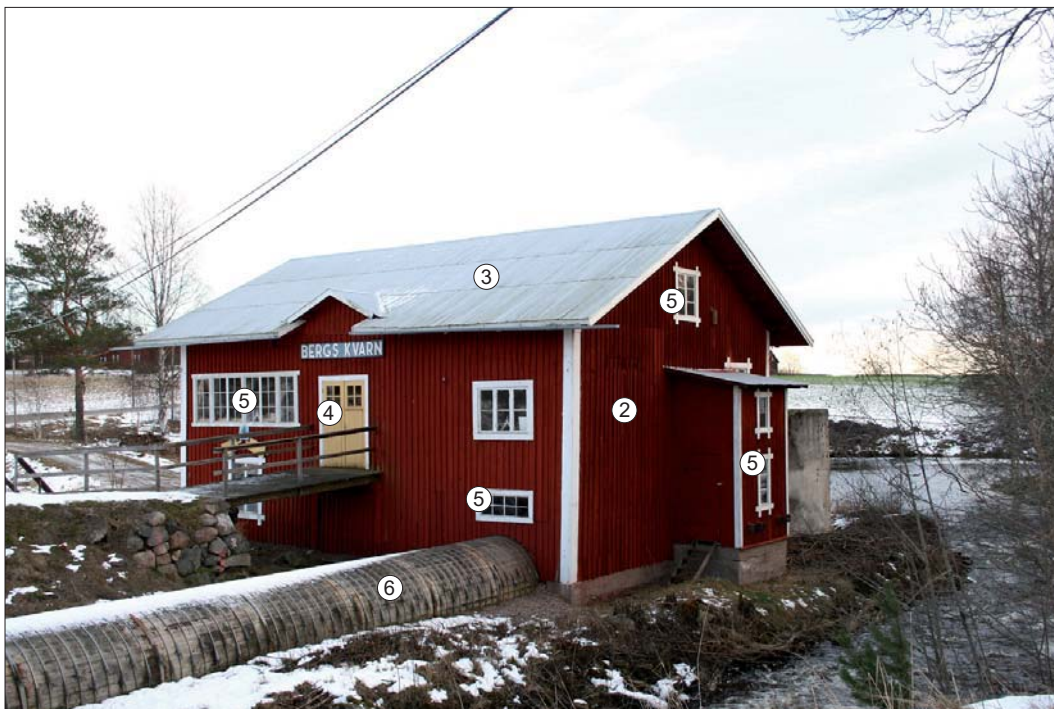
Bergs kvarn, kvarnen. Karaktärsskapande arkitekturelement markerade.
