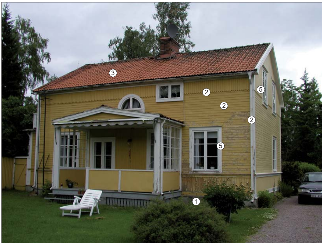
Kanalgatan 7, bostadshuset. Karaktärsskapande arkitekturelement markerade.
