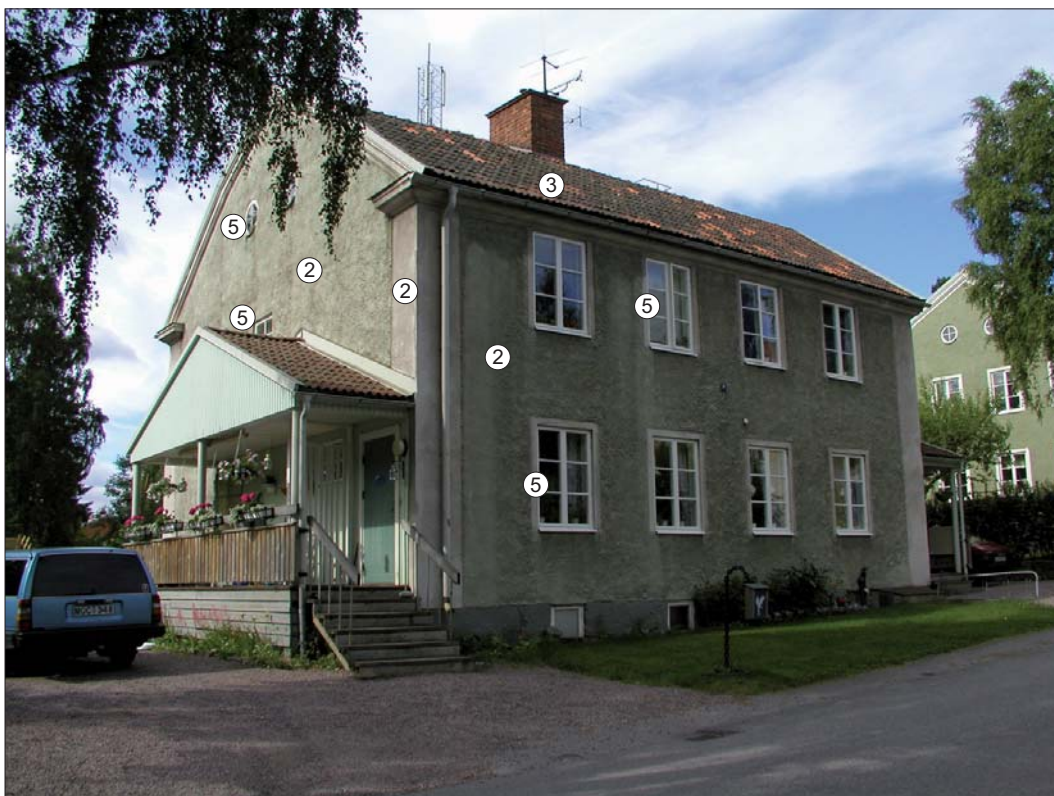
Bergsgatan 5. Karaktärsskapande arkitekturelement markerade.
