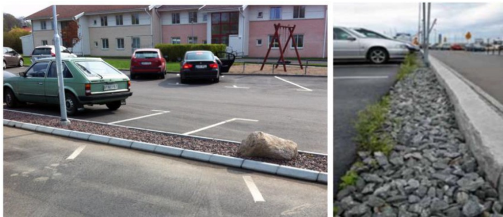
Foto som visar exempel på hur krossdiken kan utformas på parkeringsytor. Den vänstra bilden visar ett krossdike som avleder dagvatten från parkeringsyta. Dagvatten rinner in i diket via håll i kantsten (bild från WRS, källa: https://www.stockholmvattenochavfall.se/globalassets/dagvatten/pdf/md_h.pdf ) Den högra bilden kommer från Göteborg stad.
