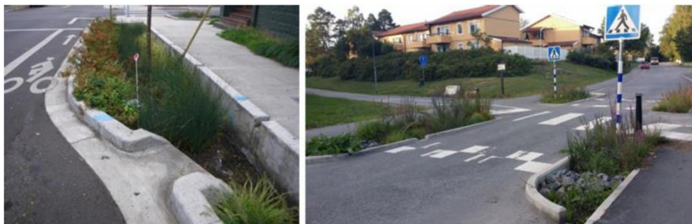
Foto som visar exempel på regnbäddar/växtbäddar i gaumiljö. Foto: Sweco.
