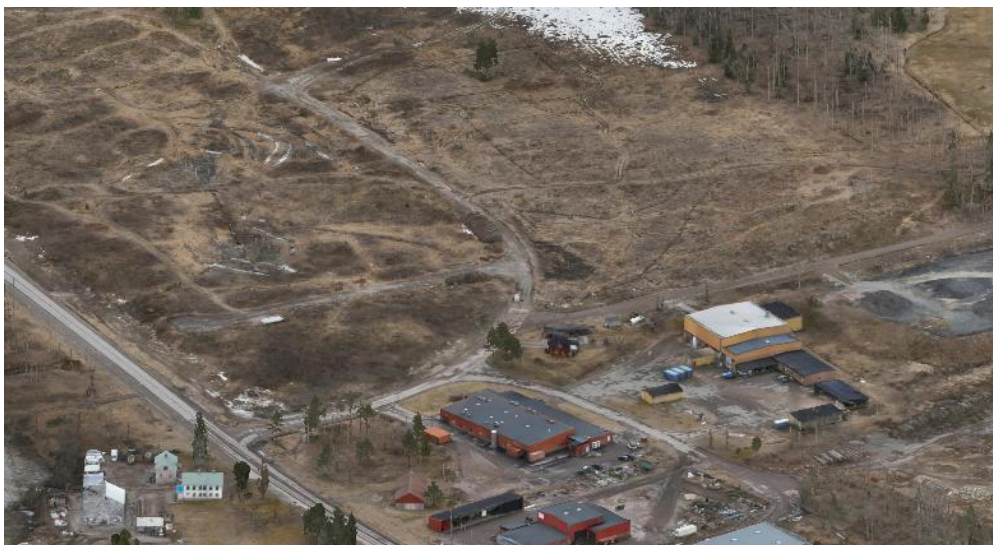
Bilden visar en del av planområdet utan exploatering. Fotot är taget i sydvästlig riktning.
