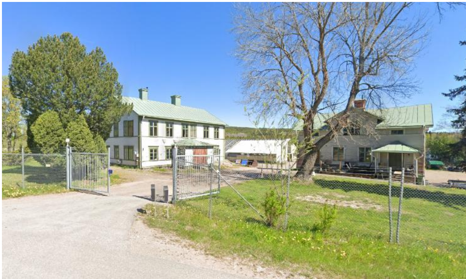
Bilden visar Böle gård som har ett kulturhistoriskt värde och inte få förvanskas genom ombyggnad och olämplig färgsättning. (källa: Google Maps)
