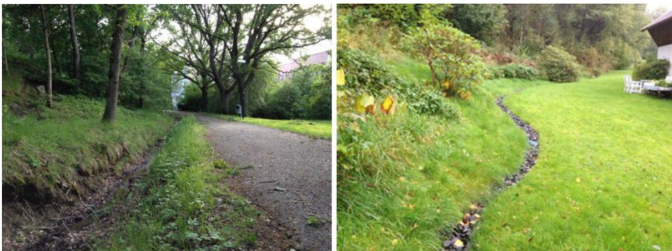
Foto som visar exempel på avskärande dike. Foto: Sweco
