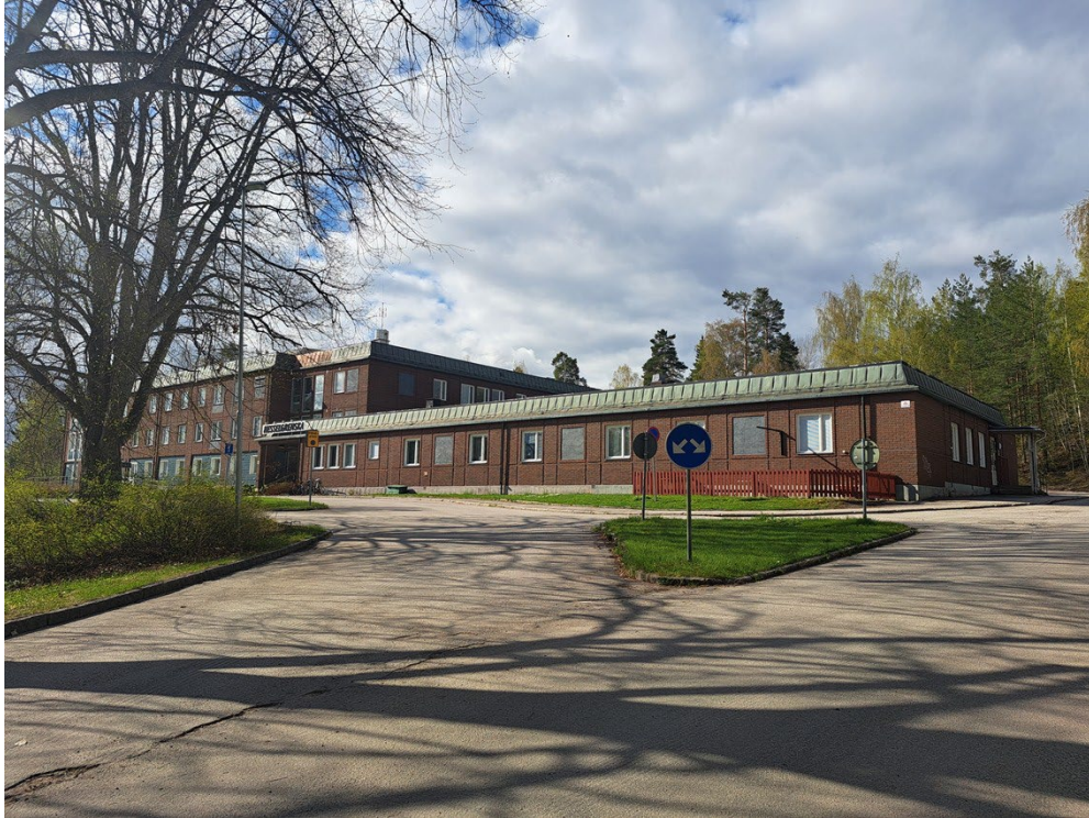
Foto som visar befintlig byggnad inom fastigheten Hofors 13:180.
