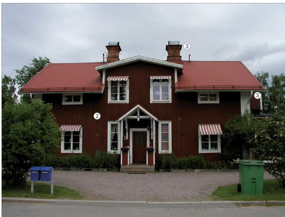
Befintlig byggnad vid Källgatan. Källa: Bebyggelse i Hofors – en byggnadsinventering (2007)
