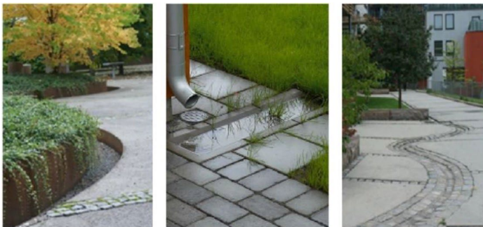
Foto som visar exempel på utformning av dagvattenrännor i urban miljö. (Det högra och vänstra exemplet är foton från Sweco, exemplet i mitten kommer från S:t Eriks rännalsplattor)
