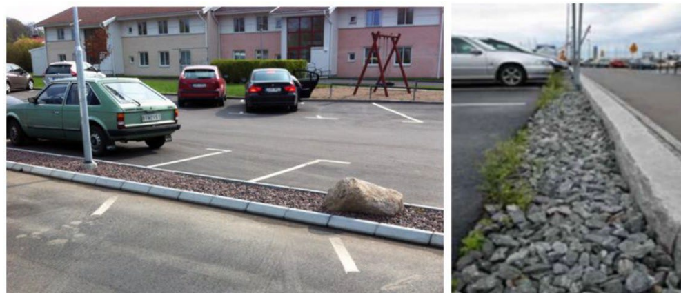
Foto som visar exempel på hur krossdiken kan utformas på parkeringsytor. Den vänstra bilden visar ett krossdike som avleder dagvatten från parkeringsyta. Dagvatten rinner in i diket via hål i kantsten (bild från WRS, källa: https://www.stockholmvattenochavfall.se/globalassets/dagvatten/pdf/md_h.pdf ) Den högra bilden kommer från Göteborg stad.
