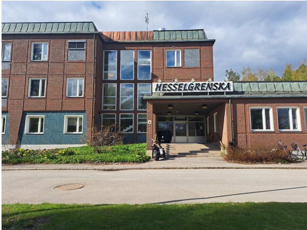
Foto över befintlig byggnads (Hesselgrenska) entrésida.
